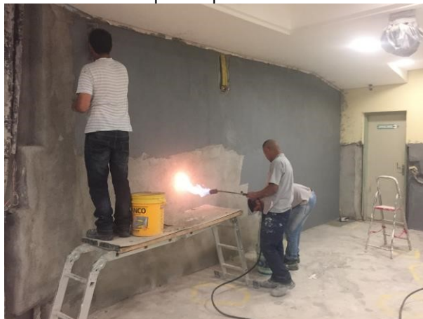
Foto ilustrativa 20: Aplicação da argamassa MK-FEN 30 (F) logo após a retirada de umidade com maçarico.
