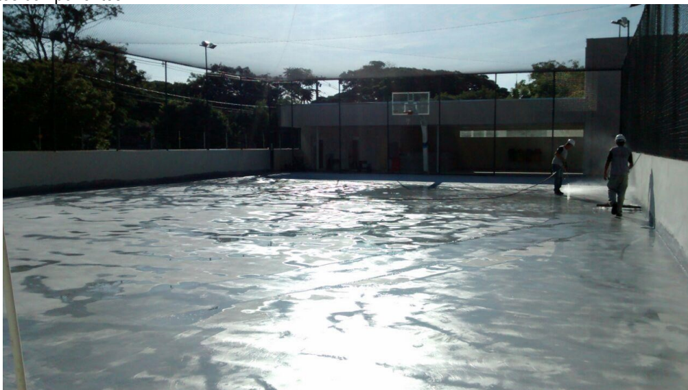
Foto ilustrativa 1: Local sendo lavado com uso de máquina de alta pressão.
