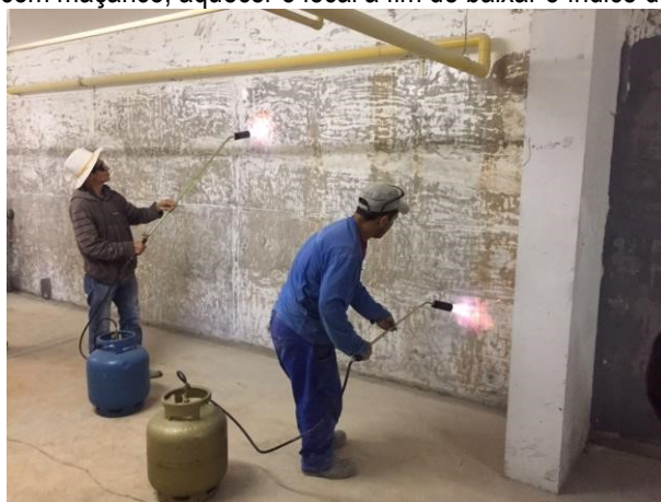
Foto ilustrativa 19: Utilização de maçarico para retirada de umidade.
