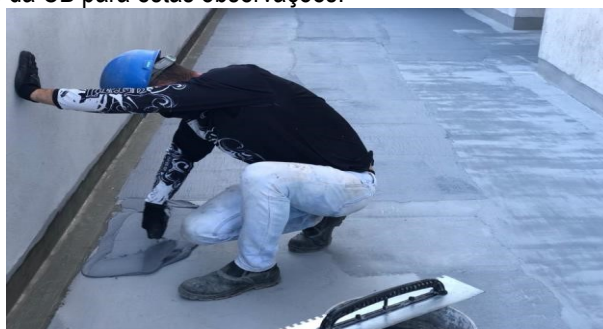
Foto ilustrativa 15: Aplicação da segunda demão da argamassa MK-FEN 30 (F) depois de finalizado o contrapiso.
