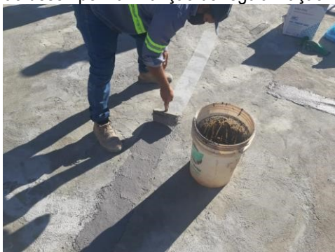
Fotos ilustrativas 5 e 6: Reparo de fissuras/trincas com o uso de tela de poliéster como reforço.
