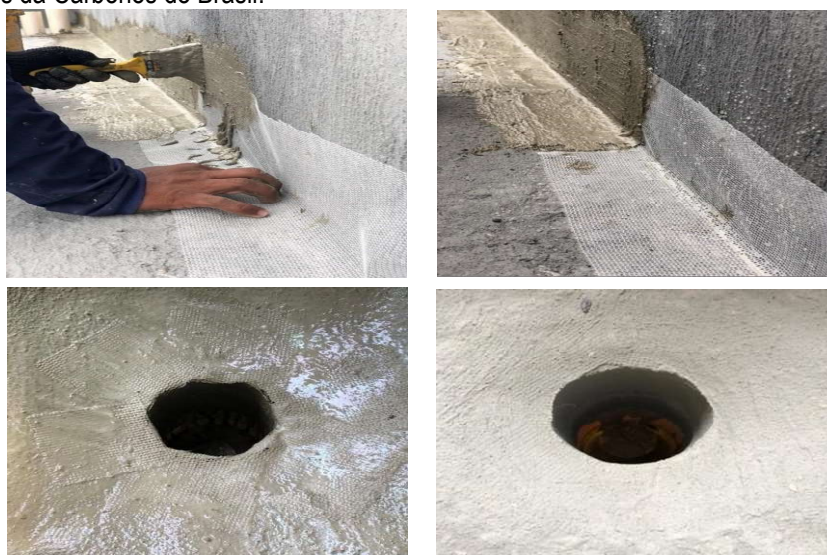
Fotos ilustrativas 11 a 14: Vista das aplicações da argamassa polimérica MK-FEN 30 - R8000 sobre a tela de poliéster em rodapés e ralos.
