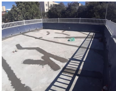
Fotos ilustrativas 5 e 6: Reparo de fissuras/trincas com o uso de tela de poliéster como reforço.
