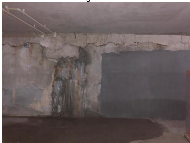
Foto ilustrativa 18: Tamponamento dos pontos de baixa resistência mecânica.
